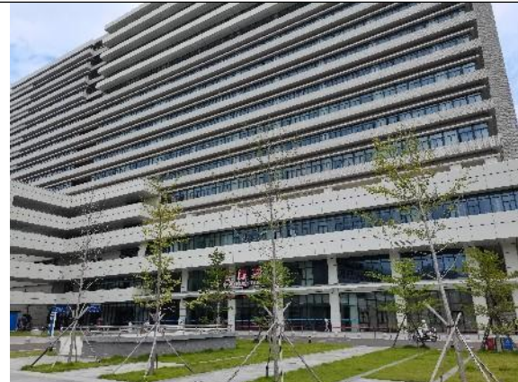
照片 1-3 门诊医技楼北侧住院楼
