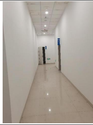
照片 1-11 拟建 DSA 机房北侧通道现状
