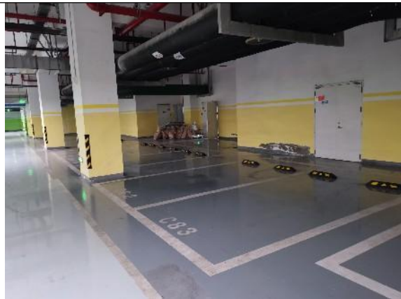
照片 1-14 拟建 DSA 机房下方地下停车场
